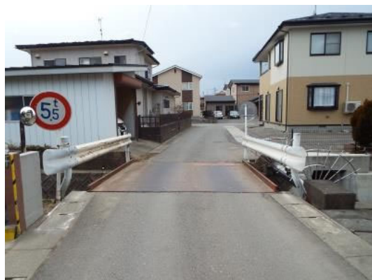
写真4-7 【全景】西の沢2号橋
