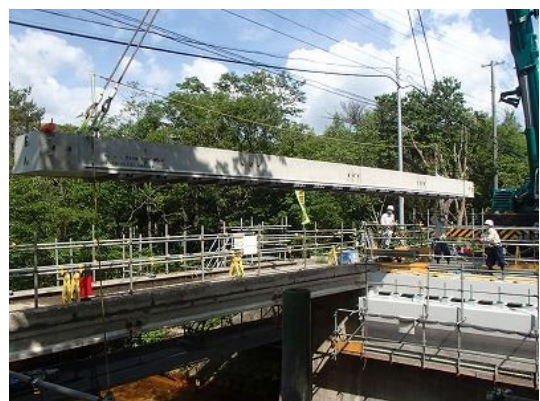
写真4-6 【対策】上部工架替
