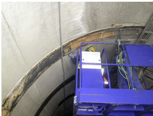
写真4-17 【損傷】漏水
