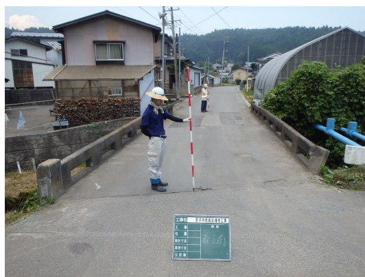
写真4-10 【全景】原子内橋
