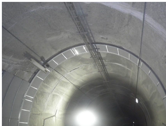
写真4-18 【対策】 導水樋工による漏水対策
