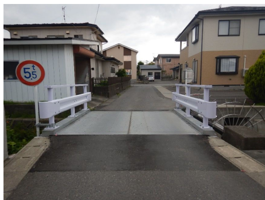
写真4-9 【対策】上部工架替
