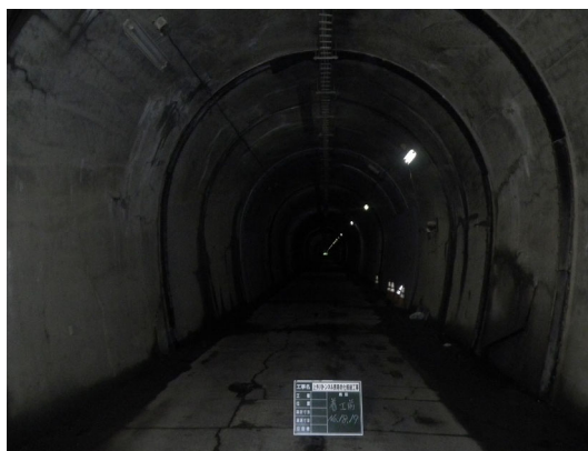
写真4-16 【全景】上外川トンネル
