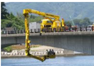
写真2-1 橋梁点検状況
