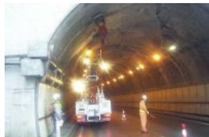
写真2-2 トンネル点検状況
