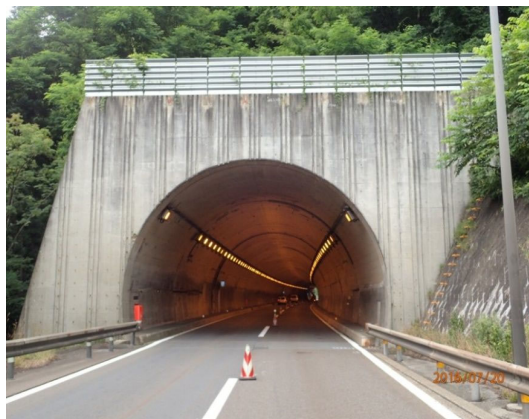
写真4-13 【全景】兄畑トンネル（下り線）
