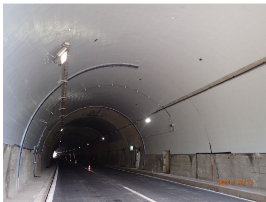
写真4-15 【対策】 断面修復および表面被覆工
