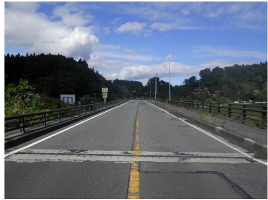
写真4-1 【全景】柳沢高架橋
