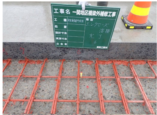
写真4-3 【対策】エンクローズ溶接完了
